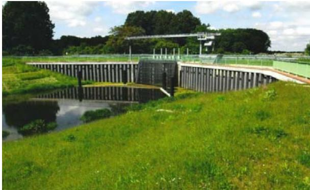
Abb. 3: Einlaufbauwerk des Etagedükers bei Dömitz.
