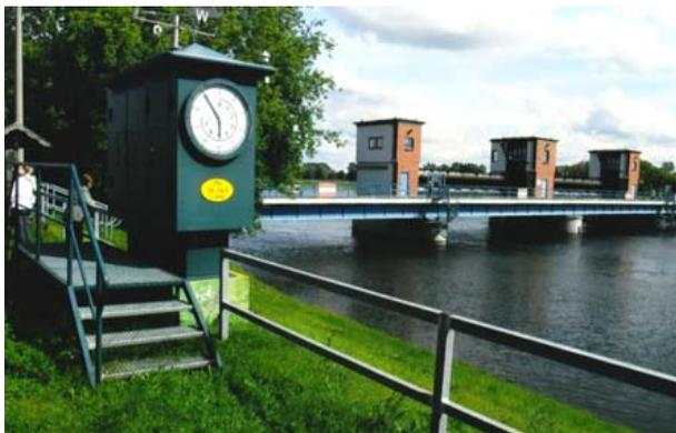
Abb. 4: Havelwehr bei Gnevsdorf mit Schreibpegel
