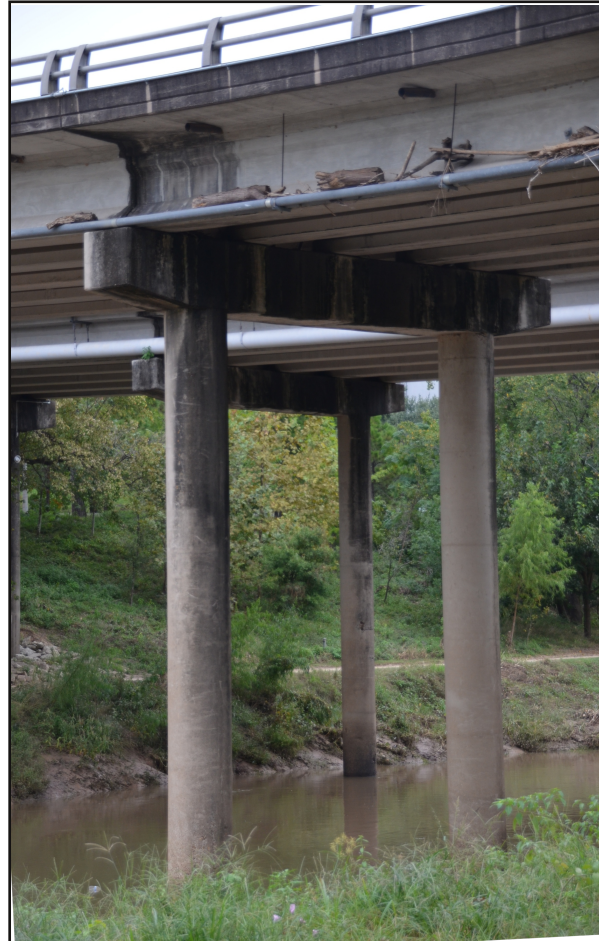
Reste von Gehölzen hängen noch heute an der Brücke über den Buffalo Bayou Fluß.
